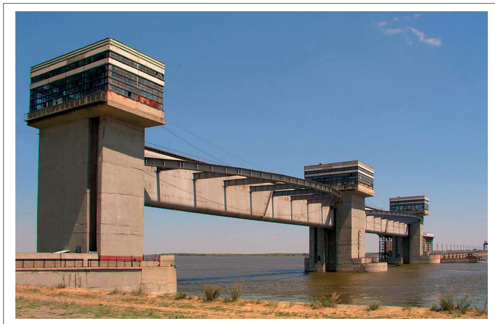
Рис.2. Волжский вододелитель (современное состояние)
